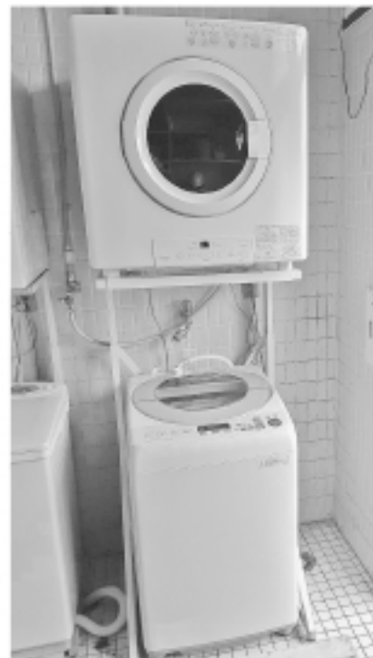
ガス衣類乾燥機の設置事例
